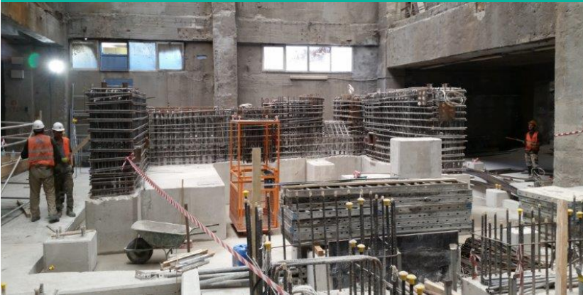
Ball Mill Foundation – Ready for final concrete pour
